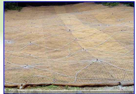
Foto 2– Verstärkungsnetz aus Stahlseilen, das vor der Auslegung fertig gestellt wurde.
